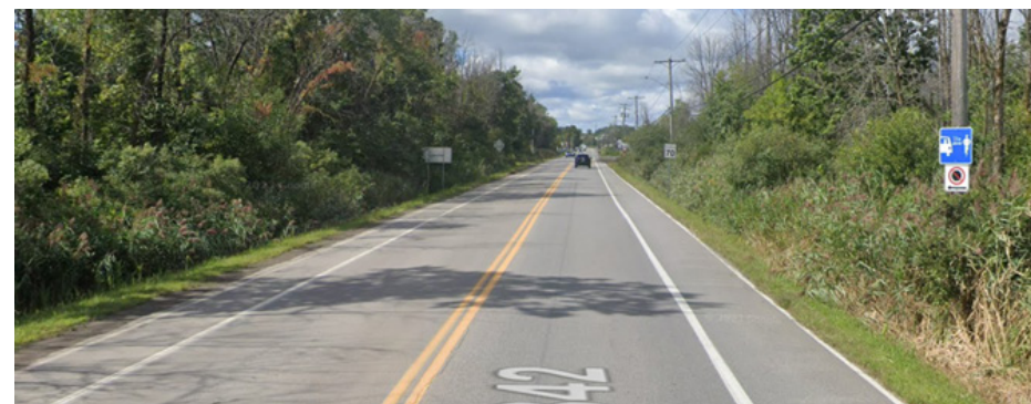
Figure 6-4 Exemple d'aménagement avec accotements revêtus sans zone tampon, route Harwood, Vaudreuil-Dorion, Québec
